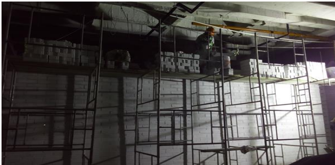
Fotografía N°1: Construcción de muro en ladrillo catalán
